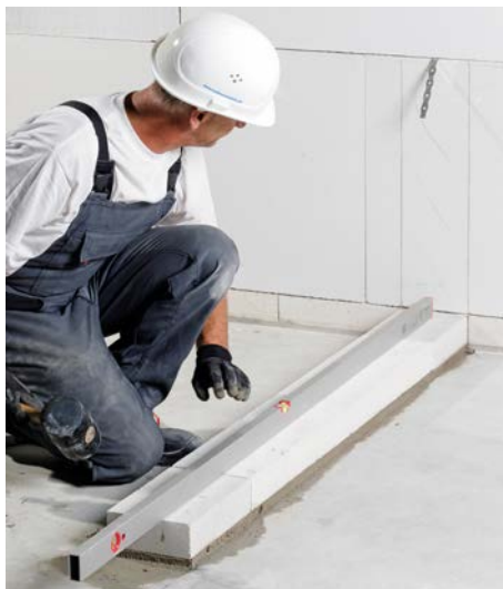
Bild 10 Kimmsteine in Längsrichtung ausrichten
