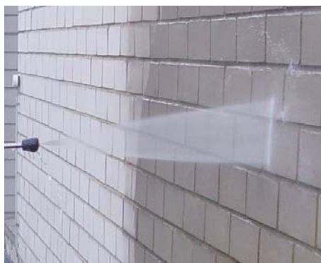
Bild 36 Reinigung mit Dampfstrahlgerät
