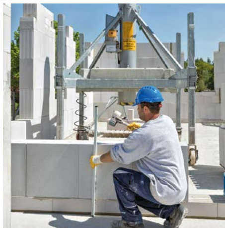
Bild 13 Eine gute Baustellenorganisation ermöglicht durchgängiges Arbeiten.
