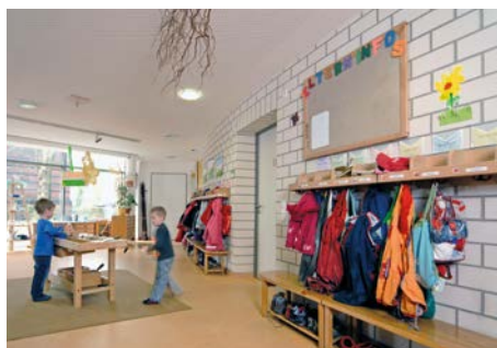
Bild 3 Innensichtmauerwerk aus KS-Verblendern
