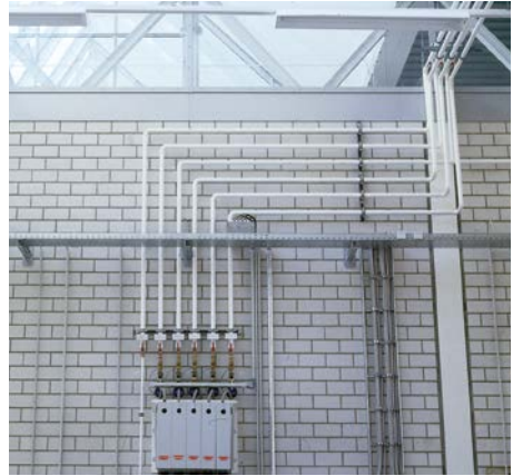
Bild 11 Innensichtmauerwerk aus Kalksandstein mit befestigten Installationsleitungen
