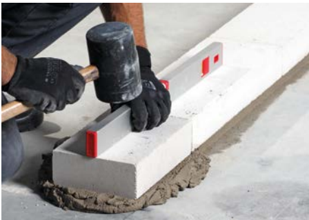
Bild 2 Kontrolle der Ebenheit in Wandlängsrichtung
