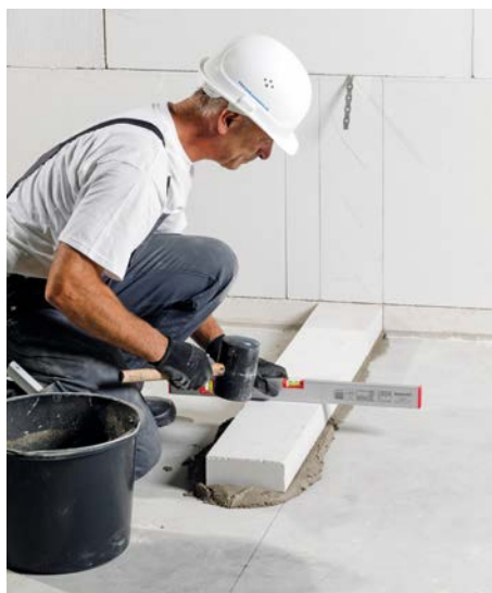
Bild 9 Kimmsteine in Querrichtung ausrichten
