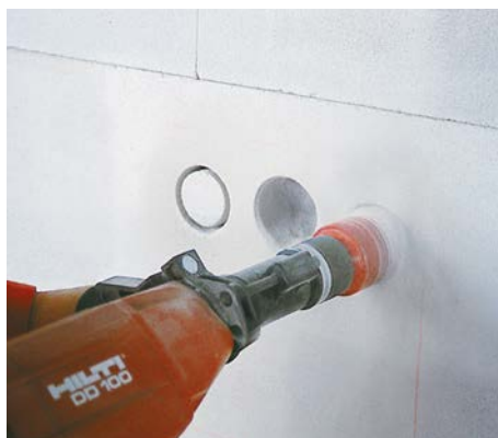
Bild 5 Fräsen von Öffnungen für Schaltdosen
