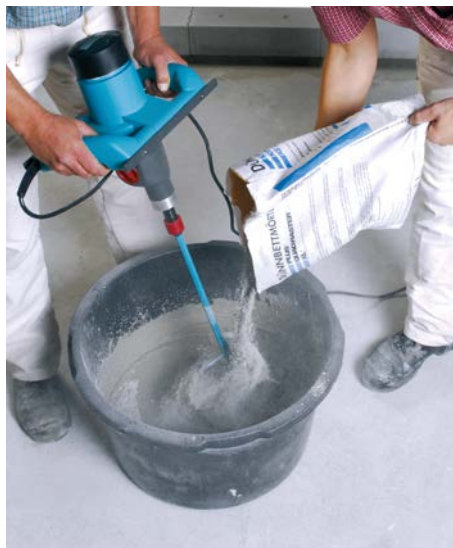
Bild 13 Der Werkmörtel wird in den Maurerkübel eingestreut.
