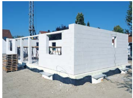
Bild 8 Eine aufgeräumte Baustelle ist die beste Werbung.
