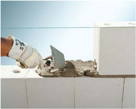
Bild 4 Verarbeitung von Normalmauermörtel
