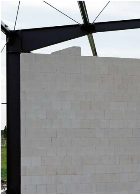
Bild 24 Kalksandstein-Mauerwerk als Ausfachung einer Stahlkonstruktion
