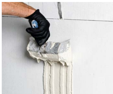
Bild 54 Für das Aufmauern der Querwand wird für den Stumpfstoß Dünnebettmörtel aufgezogen.
