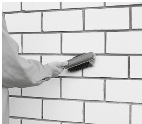
Bild 31 Eventuell vorhandene Mörtelreste sind abzufegen.
