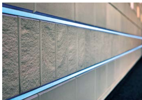
Bild 4 Innensichtmauerwerk aus KS-Fasensteinen kombiniert mit LED-Technik
