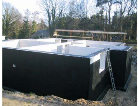
Bild 3 Kellerwand-Außenseite mit PMBC-Abdichtung
