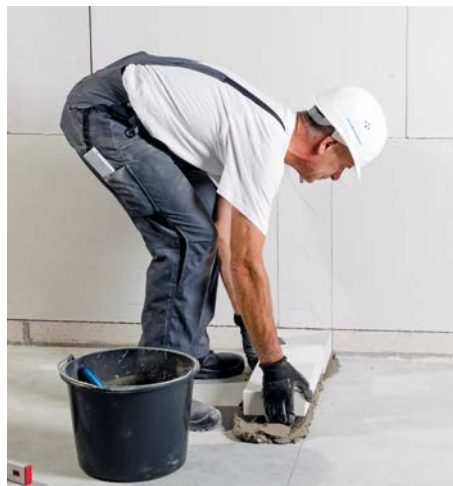
Bild 7 Kimmstein ins Mörtelbett verlegen
