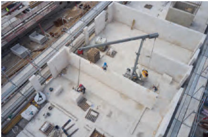
Bild 16 Modulares Bauen: hier mit KS XL
