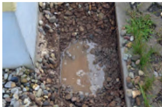
Bild 24 Kiesstreifen, in dem sich Wasser ansammelt und so an Sockeln zur Erhöhung anstelle zur Verringerung der Beanspruchung führt
