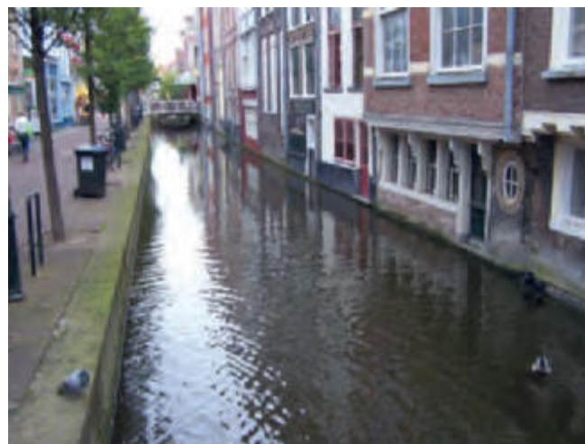
Bild 3 Historische Gebäude an einer Gracht in Delft. Die gemauerten Wände sind nur in Höhe des Wasserspiegels erkennbar nass, unmittelbar darüber aber trocken
