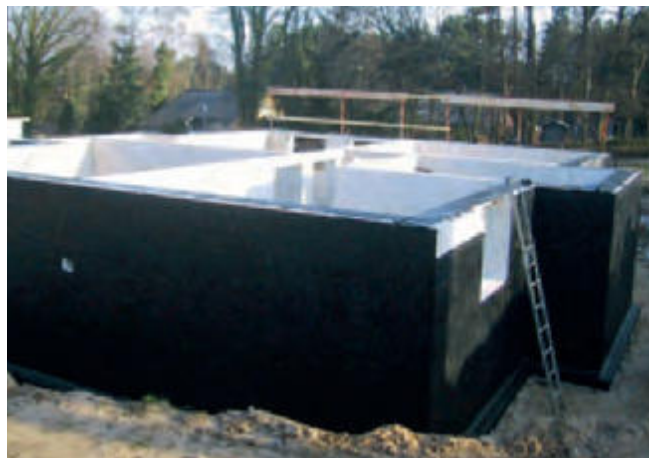
Bild 34 Kellerwand-Außenseite mit PMBC-Abdichtung
