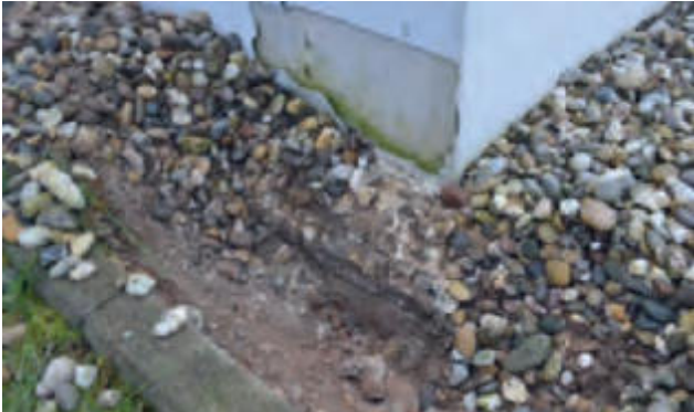
Bild 25 Die Schäden am Sockel waren auf eine fehlerhafte Abdichtung zurückzuführen
