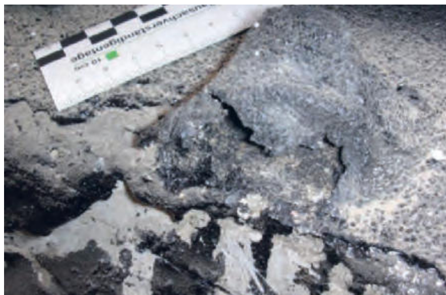
Bild 32 Aus Zuverlässigkeitsüberlegungen sollten auch bei der geringen Wassereinwirkung E1 Abdichtungen an Beton von Bodenplatten hinterlaufsicher angeschlossen werden und nicht, wie hier im Bild, auf einen nicht vorbehandelten Untergrund aufgetragen werden. Damit kann bei eventuell später auftretender, geringen Stauwasserbildung an den unteren Wandenden Wasserschäden im Gebäude verhindert werden
