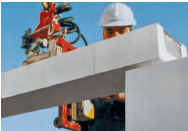
Bild 24 Vorgefertigte KS-Flachstürze zur schnellen und rationellen Öffnungsüberdeckung
