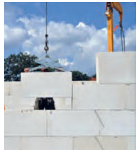
Bild 21 Maschinelles Versetzen von KS XL-Planelementen
