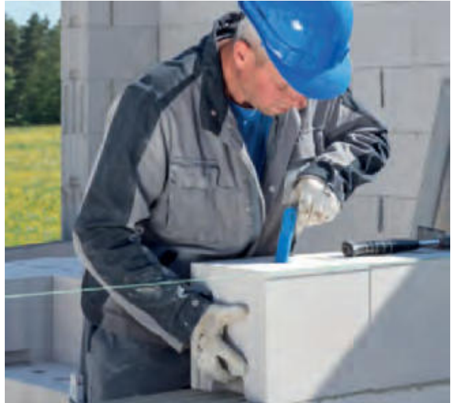
Bild 18 KS-R-Plansteine für Dünnbettmörtel
