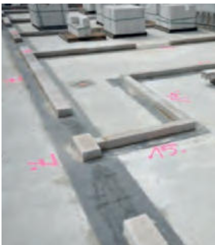
Bild 19 Anlegen der Kimmerschicht
