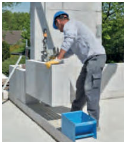
Bild 20 Versetzen von KS XL in Dünnbettmörtel
