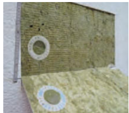
Bild 25 Versenkt eingebaute Dämmstoffdübel
