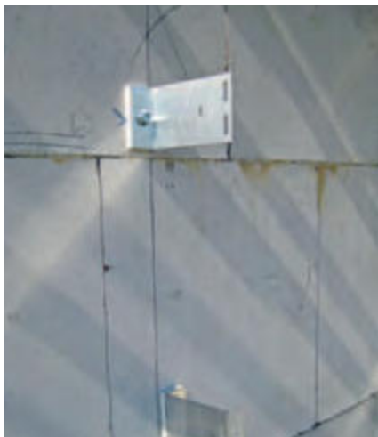
Bild 35 Vorgehängte hinterlüftete Fassaden mit Aluminium-Unterkonstruktion
