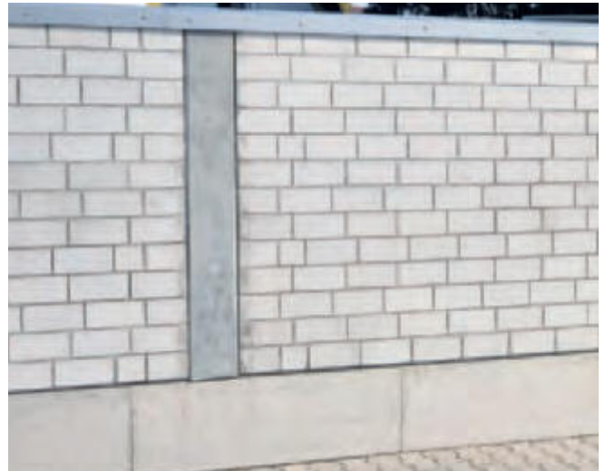
Bild 43 Freistehende KS-Wand mit horizontalen und vertikalen Aussteifungen
