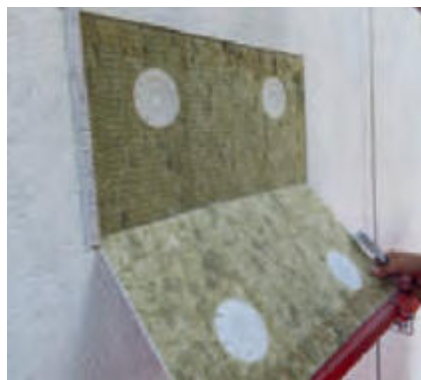
Bild 24 Oberflächenbündig eingebaute Dämmstoffdübel
