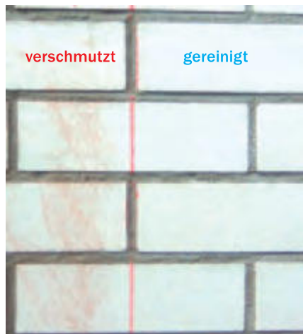
Bild 10 Reinigungseffekt, Beispiel Reinigung mit Schleifpapier, Körnung 140
