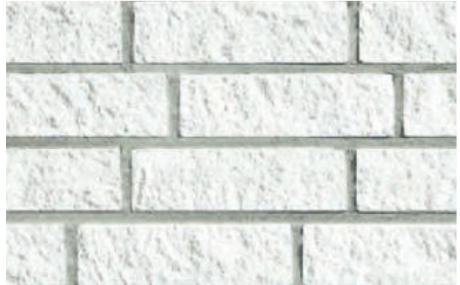
Bild 2 Sichtmauerwerk aus bruchrauen KS-Verblendern, Format NF
