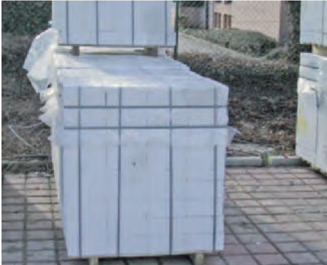
Bild 19 Lagern von Steinen mit Schutz gegen Niederschlag
