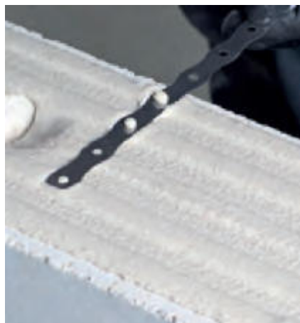
Bild 33 Stumpfstoßtechnik: Mörtelbett mit Edelstahl-Flachanker
