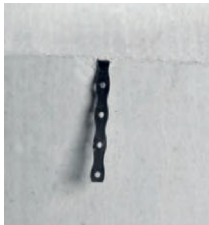
Bild 34 Stumpfstoßtechnik: Abgewinkelte Edelstahl-Flachanker (Bauphase) in Achse der anschließenden Wand
